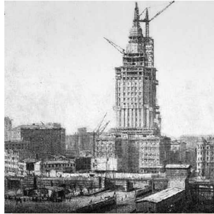
Стройка близится к завершению. Начало 1950-х годов Construction is Nearing the Completion. Early 1950s
